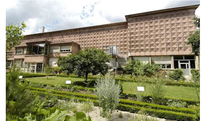
Muséum-Aquarium de Nancy (préfabrication béton - 1933) Photo : Mapstr.com
